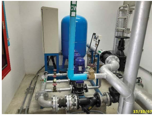
Booster Pump อาคาร X
